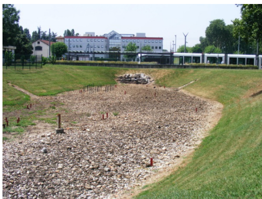
Figure 5 : instrumentation du site de l'IUT.
