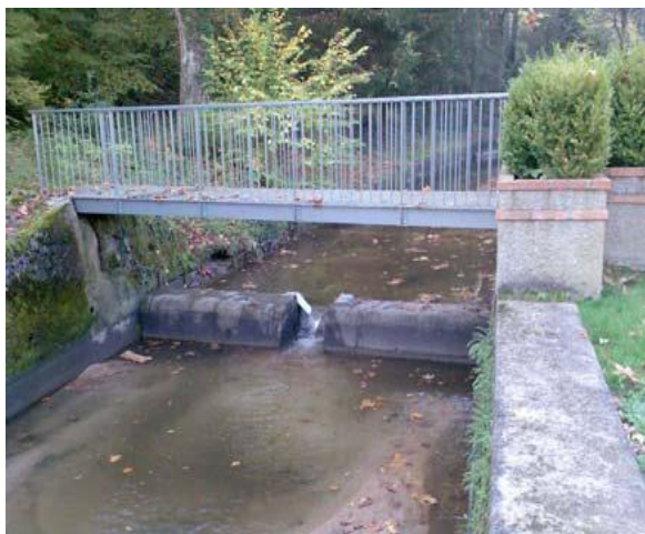
Figure 47. Station de la rivière Charbonnières à Charbonnières-les-bains
