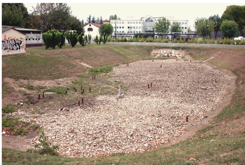
Figure 10. Instrumentation du site de l'IUT. En 2008, le bassin d'infiltration comprend un total de 61 piézomètres, tubes en plexiglas ou tubes métalliques permettant d'échantillonner et d'inspecter par vidéo-caméra le lit d'infiltration et la nappe phréatique. Cette instrumentation a été complétée par 24 piézomètres métalliques permettant l'échantillonnage du toit de la nappe tous les 20 cm.
