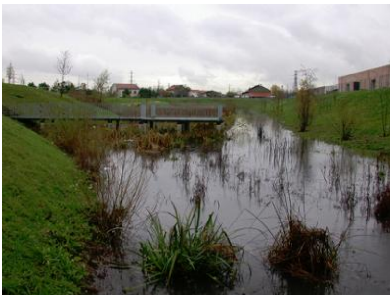
Figure 14: bassin d'infiltration d'eau pluviale Minerve, commune de St Priest (photo : Umr 5023 G. Bouger).
